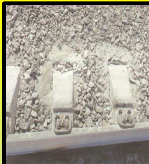
Рис. 1. Общий вид выплеска (134 км ПК7 перегона Голутвин–Луховицы Московской дороги)
