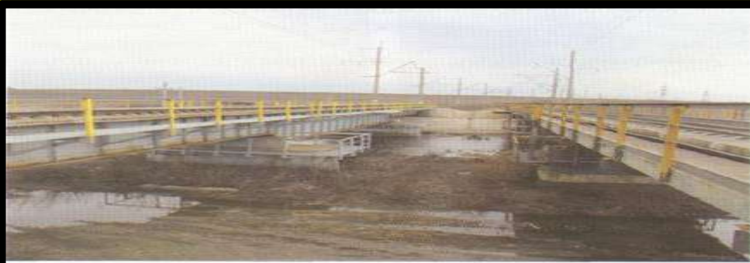
Рис. 1. Металлический железнодорожный мост через реку на полигоне Приволжской дороги
